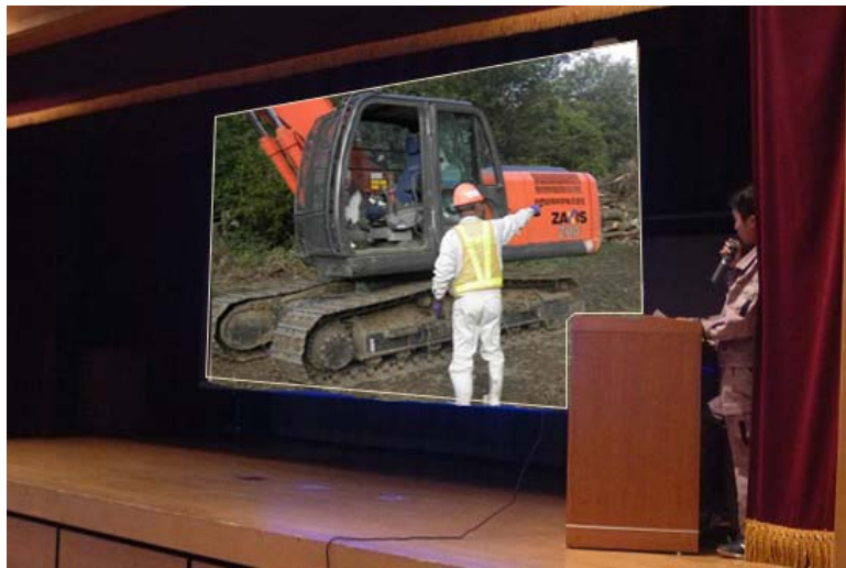
木曽川維持工事 現場代理人 加藤建設（株）森腰拓未さん
