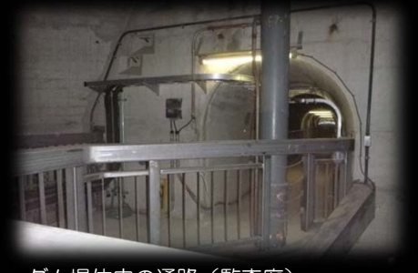
ダム堤体内の通路（監査廊）
