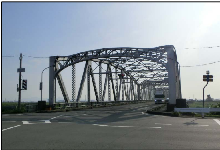
揖斐大橋の西詰交差点付近（平成26年9月）
