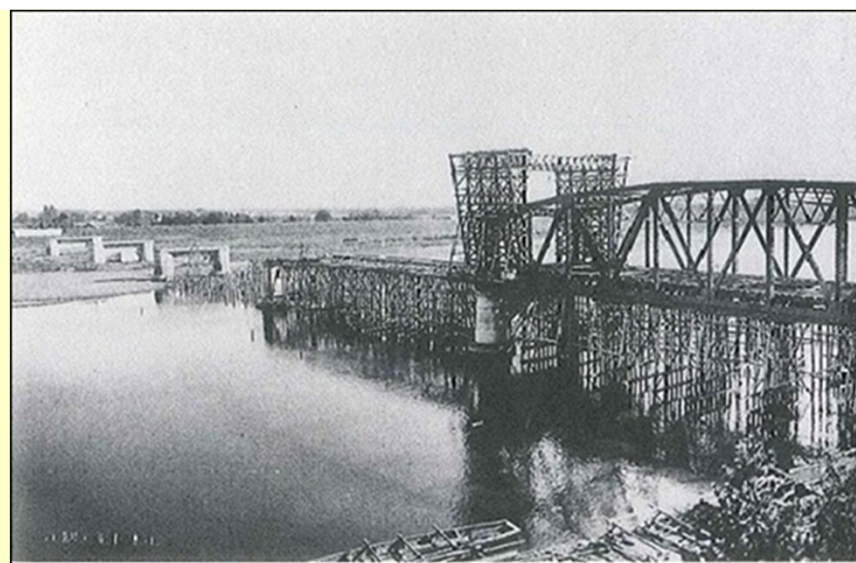
長良大橋の建設状況（昭和初期） 出典：ふるさと大垣
