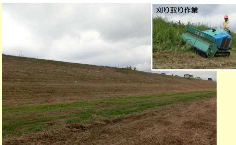
堤防斜面の刈草完了状況 7月14日撮影 (大垣市東町)
