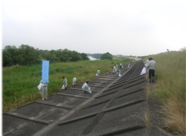
揖斐川左岸(川裏)活動状況
