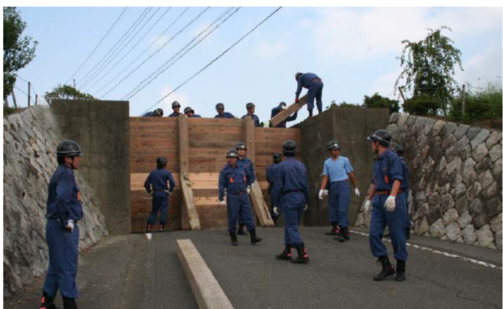
輪中堤切り割り封鎖訓練 (写真：輪之内町提供)
