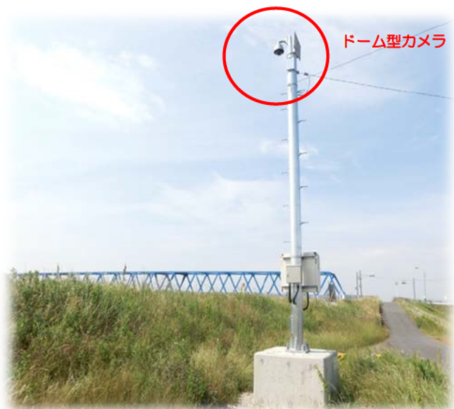
揖斐川・福束大橋地点の河川監視カメラ設置状況
