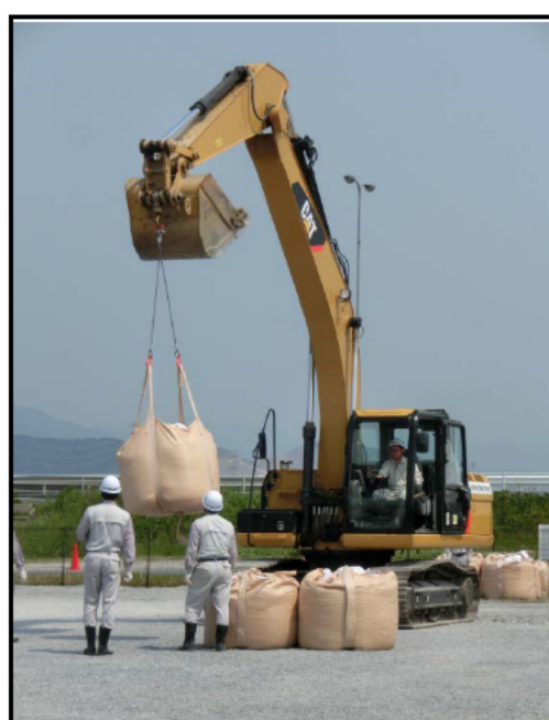
大型土のう工の実演（岐阜県西濃建設業協会）
