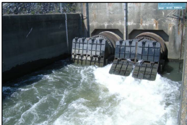
排水ゲートからの吐き出し状況の点検 （新水門川排水機場：平成26年4月11日）
