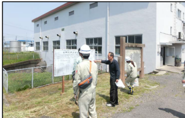
新水門川排水機場周辺の施設点検（平成26年5月9日）
