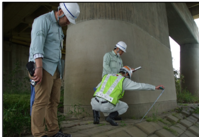
名神杭瀬川橋梁：平成26年5月15日
