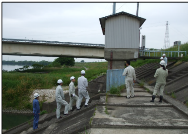
福束輪中排水機樋管：平成26年5月15日
