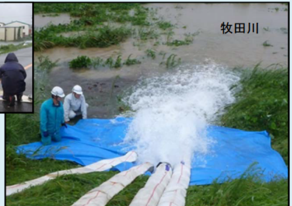
排水ポンプ車による排水状況
