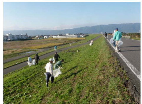
揖斐川左岸34.0Kp付近 輪之内町南波地先
