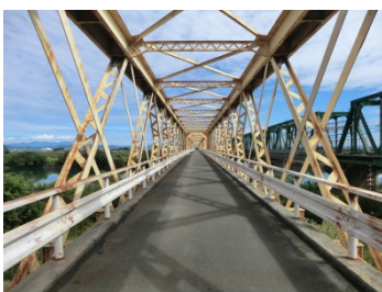
アスファルト舗装された橋面部 （大垣市新開町）
