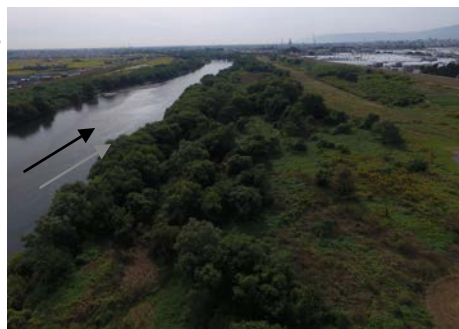
樹木伐開箇所の繁茂状況（上流から望む）
