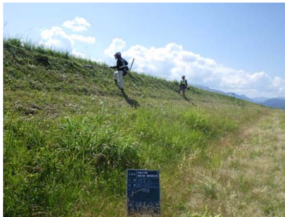
肩掛け式除草機による堤防除草
