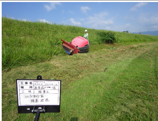
大型除草機（ハンドガイド型）による堤防除草
