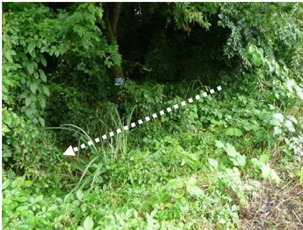
閉塞し草地化している水路(中池下流)
