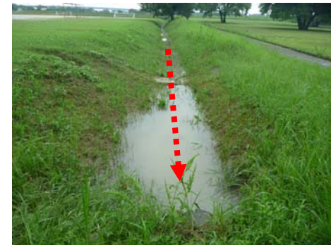
降雨時の排水路の状況
