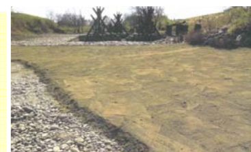
②トンボ池: シードバンク敷設
