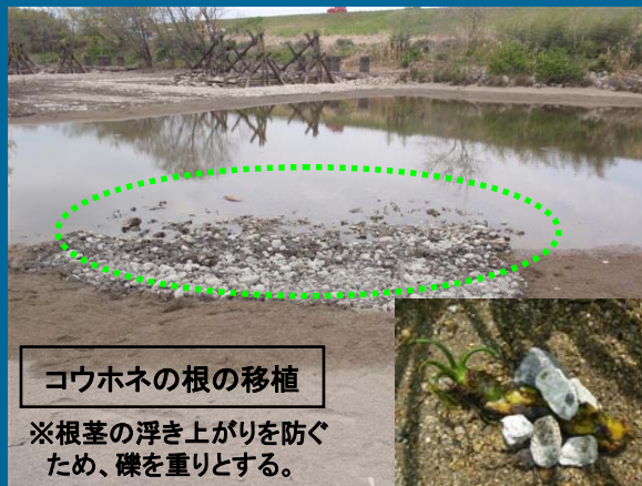
底泥(シードバンク)と粗砂を混ぜ敷設した。 (平成23年4月1日)
