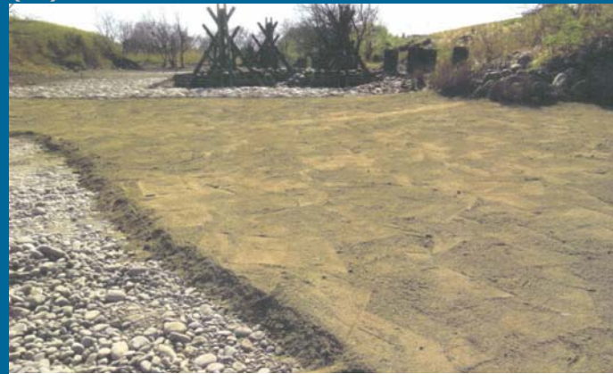
底泥(シードバンク)と粗砂を混ぜ敷設した。 (平成23年4月1日)
