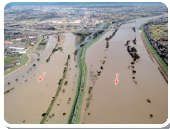
まきたがわ くせいがわ いびがわ 牧田川、杭瀬川、揖斐川の出水状況 (平成16年10月洪水)
