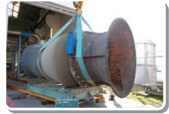
しんすいもんがわ 新水門川排水機場の 1号主ポンプ老朽化状況
