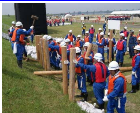
水防団による水防工法 (杭打ち積み土のう工)
