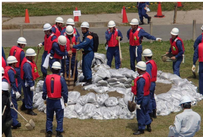
メイン会場 水防団による水防工法(釜段工)
