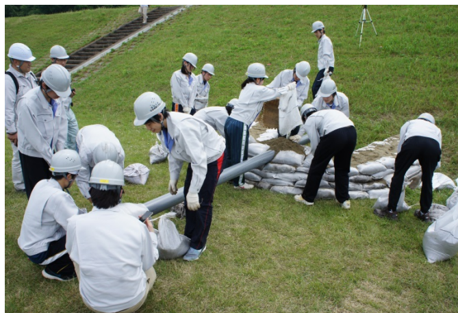
メイン会場 大学生による水防工法(月の輪工)
