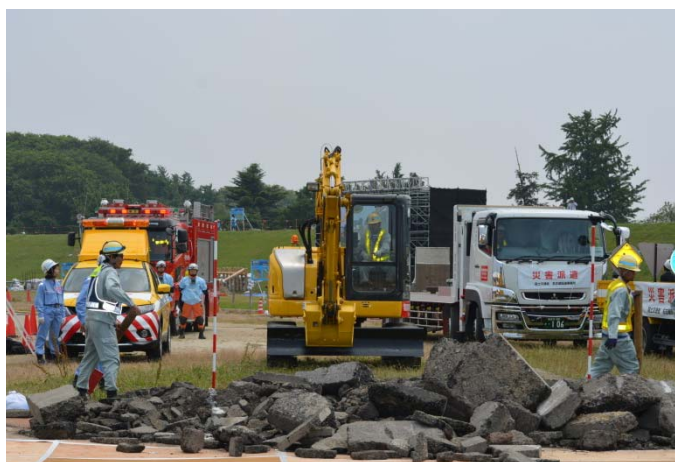
メイン会場 国土交通省及び関係機関が連携した道路啓開
