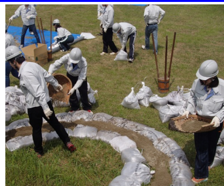
大学生による水防工法 (月の輪工)
