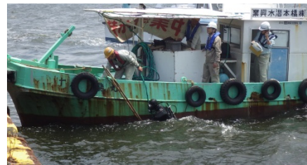
潜水士による被災状況調査
