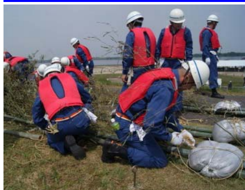
水防団による水防工法 (竹流し工)
