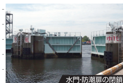
水門・防潮扉の閉鎖
