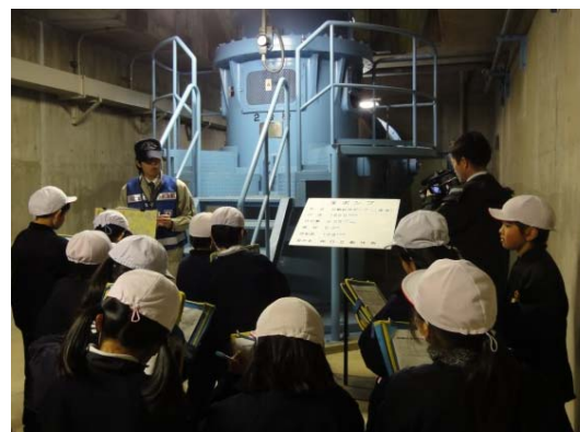
ポンプ室の見学
