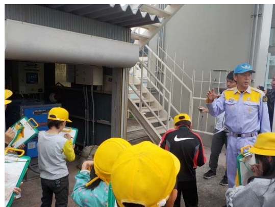
忠節用水逆水樋門の見学
