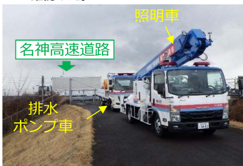
高速道路堤防道路を連結する開口部から排水作業現場までの走行訓練の様子(①)
