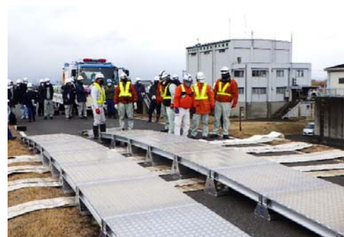
排水ホースの上を車両が通行するための仮設ブリッジの設置訓練の様子(③)
