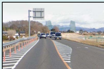
木曽川上流管内における 堤防天端道路(羽島市)
