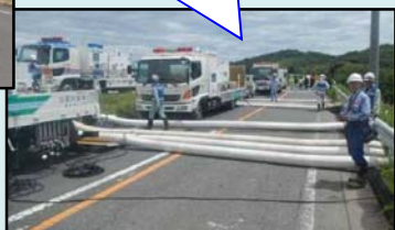
【参考】平成30年7月豪雨時における 排水作業(岡山県)
