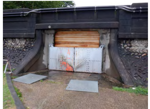
起陸閘の閉鎖状況
