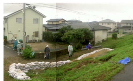
漏水の進行による堤防決壊の恐れ
