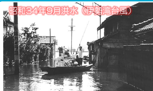
旧長島町（現桑名市）の浸水状況
