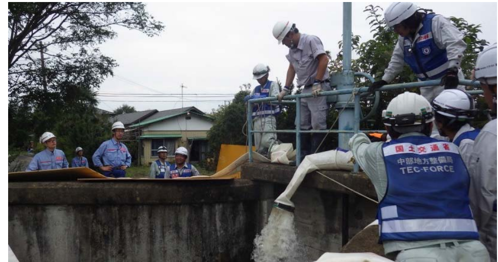
【排水ポンプ車による排水作業（北上川水系出来川）】
