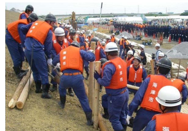
【揖斐川連合総合水防演習・広域連携防災訓練】 19
