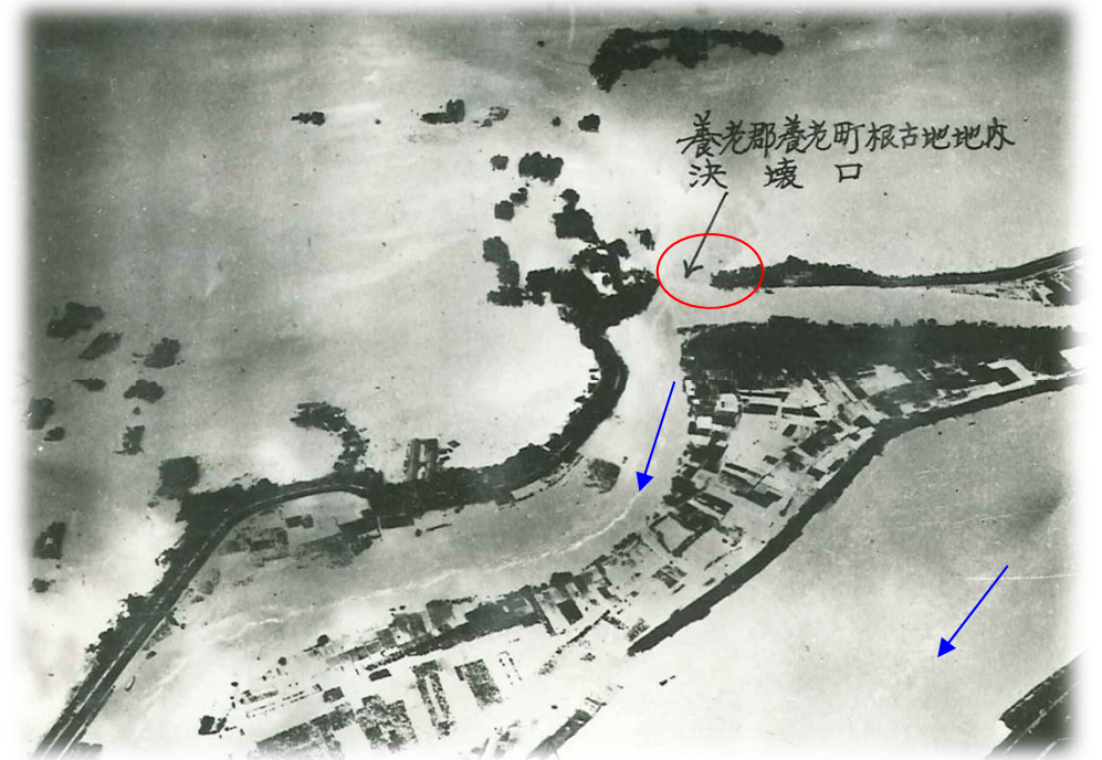
牧田川破堤状況 （養老町多根古地地先）
