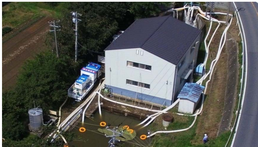
【排水ポンプ車による排水作業（北上川水系出来川）】
