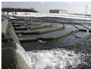
図 5-2.4 第七床止め魚道(根尾川)
