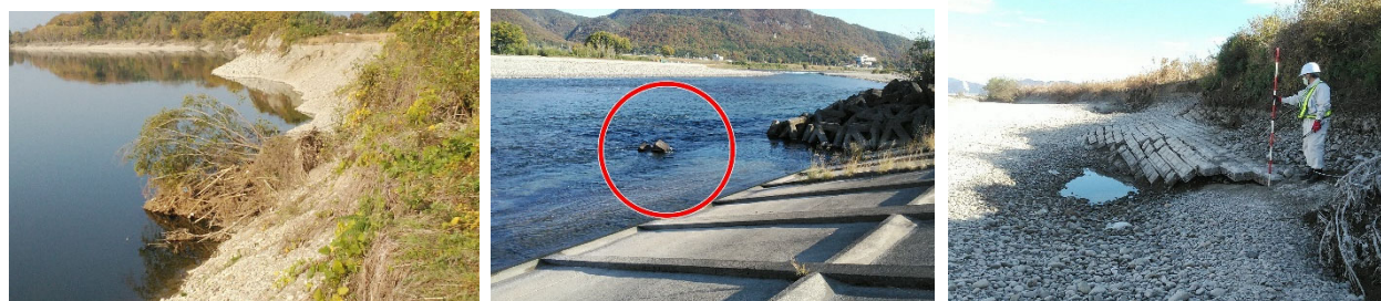
河岸の侵食 (木曾川右岸44.4k付近)
