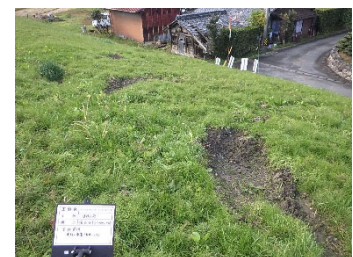
陥没状況（揖斐川36.6km付近）
