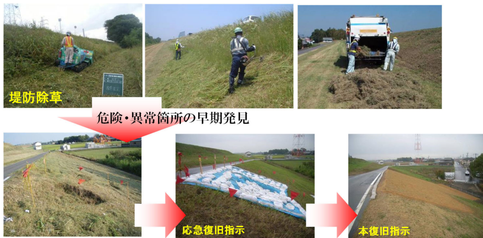
図 5-3.1 堤防除草の様子
