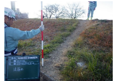
侵食状況（木曽川51.2km付近）
