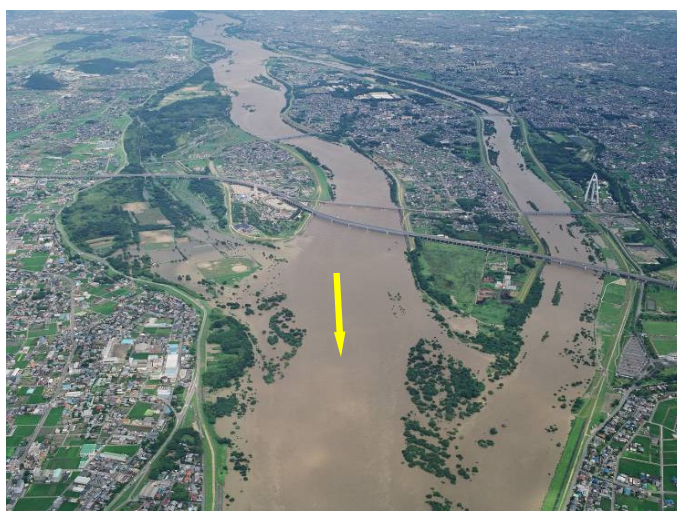
木曾川 42.8k 付近より上流 (2006.07.19)
