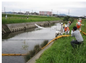
オイルフェンス設置状況
