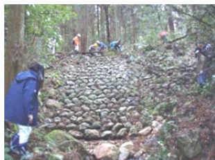
砂防堰堤の測量状況
