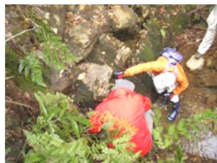
砂防堰堤基礎の確認
