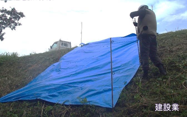
はしま 長良川(羽島市) 応急復旧作業
