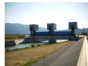
泥川水門(平成23年完成)岐阜県
