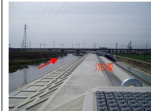
大谷川洗堰嵩上げ(1.05m) (平成19年完成)岐阜県
