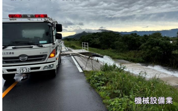
ようろ 牧田川(養老町) 排水ポンプ車の操作
