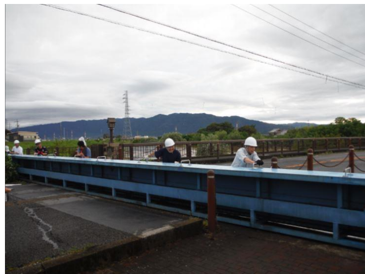
塩田橋陸閘の閉鎖状況
