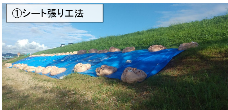
応急復旧完了 (8月18日17時頃)
