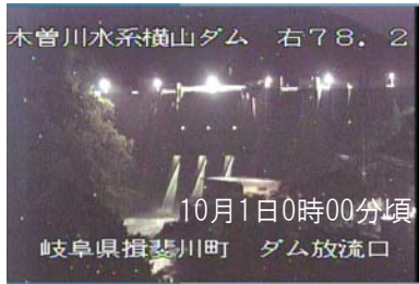
横山ダム放流状況
