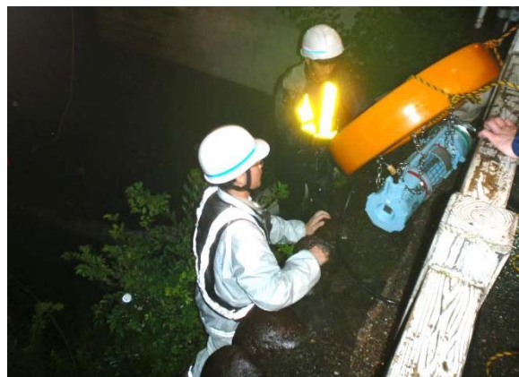
排水ポンプ車設置・稼働状況 (7月8日)
