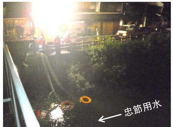
排水ポンプ車設置・稼働状況 (7月8日)
