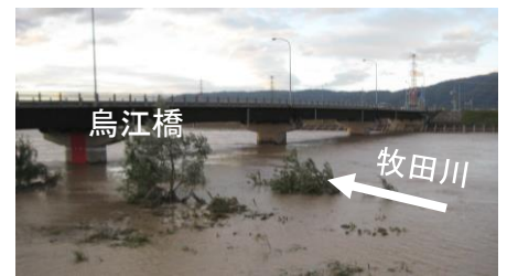
＜平成29年台風第21号出水の状況＞
