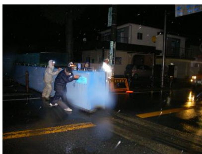
塩田橋右岸陸閘閉鎖作業中
