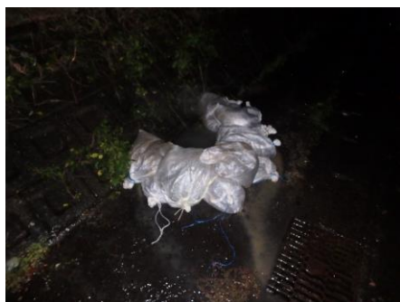
牧田川10.4k付近 月輪工法
