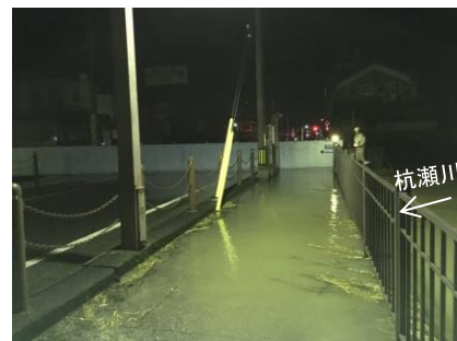
塩田橋の道路面よりも水位が上昇
