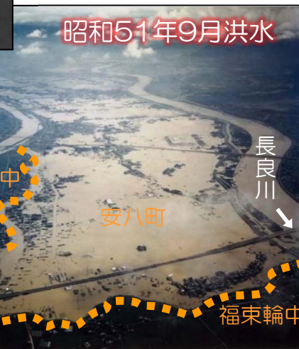
長良川右岸浸水状況
