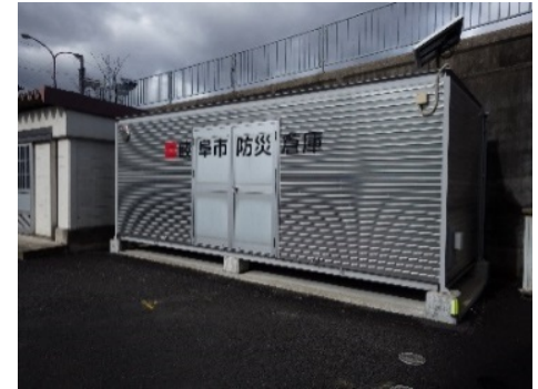
岐阜小学校にある防災倉庫
