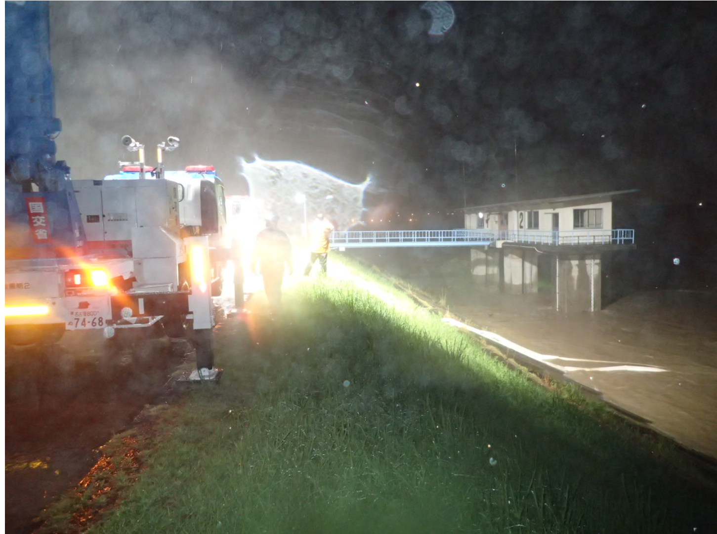
みのかもし はいすい しゃ さぎょう ようす しりょうていきょう こくどうつうしょう じょうりゅうかせんじむしょ 美濃加茂市における排水ポンプ車による排水作業の様子（資料提供：国土交通省 木曾川上流河川事務所）
