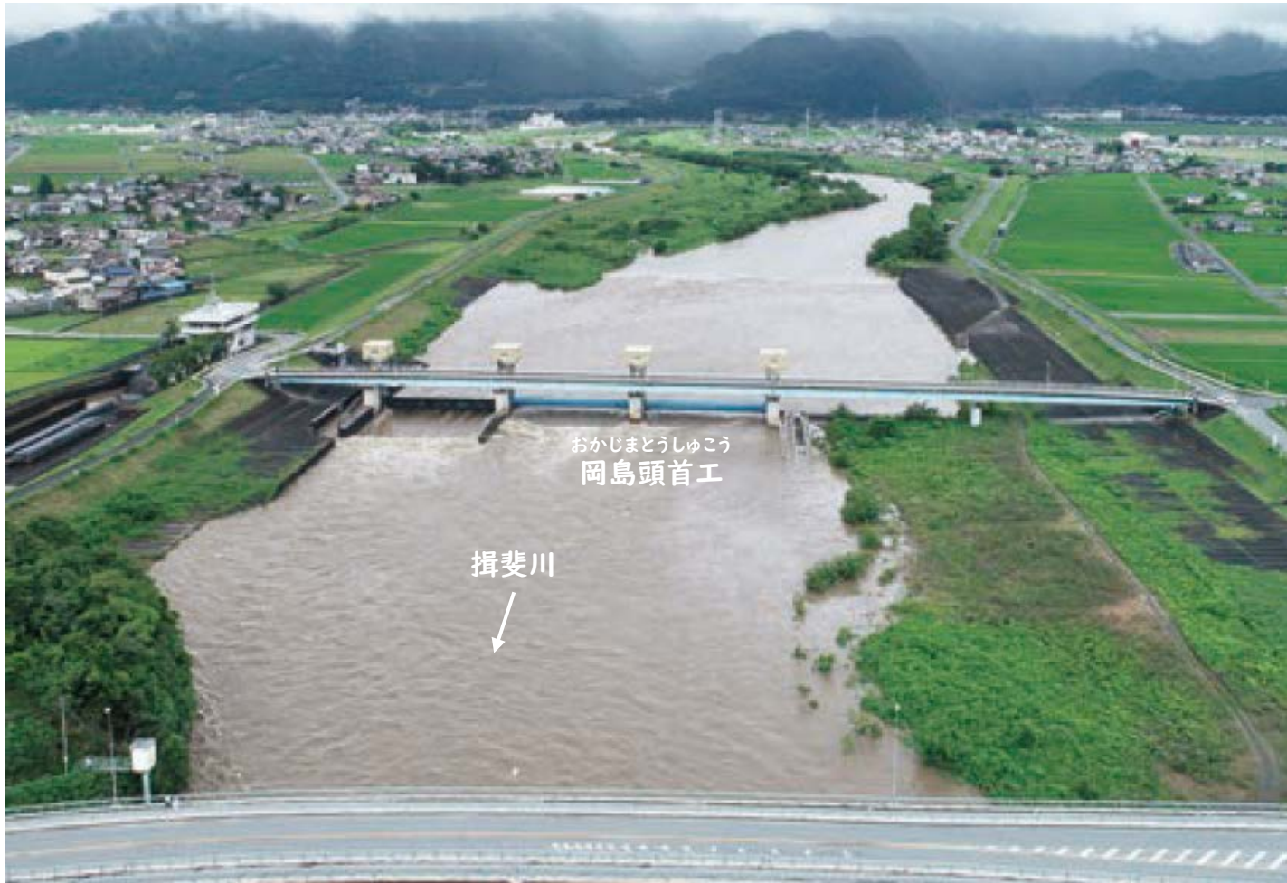
ちょう おかじまとうしゅこうふきん ようす しりょうていきょう こくどうつうしょうきそがわじょうりゅうかせんじむしょ 揖斐川町岡島頭首工付近の様子（資料提供：国土交通省 木曾川上流河川事務所）
