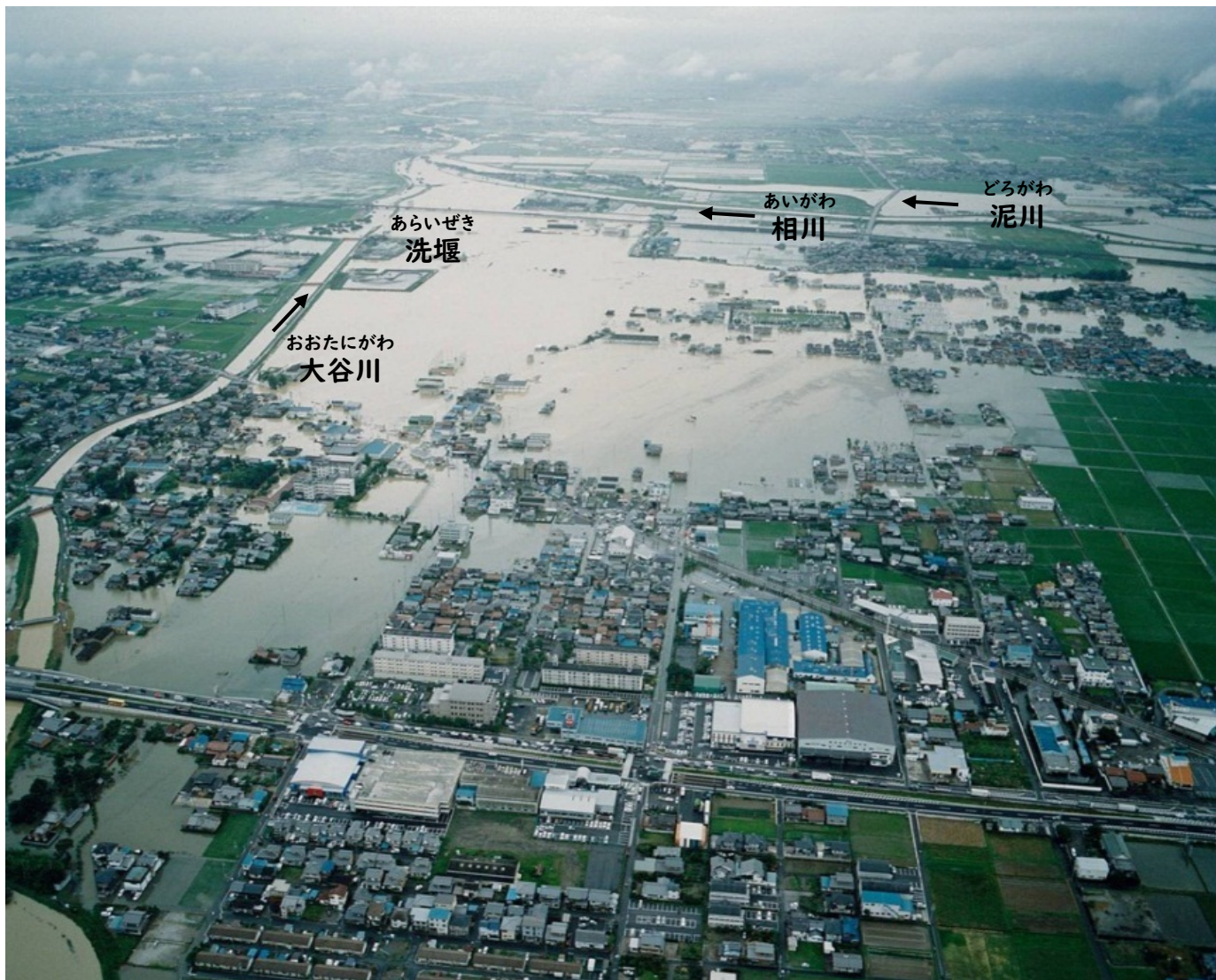
あいがわ おおたにかわ どろがわごうてんりゅう ふきん しりょうていきょう こくどうつうしょうきそがわじょうりゅうかせんじむしょ 相川・大谷川・泥川合流点付近の様子 (資料提供：国土交通省 木曾川上流河川事務所)
