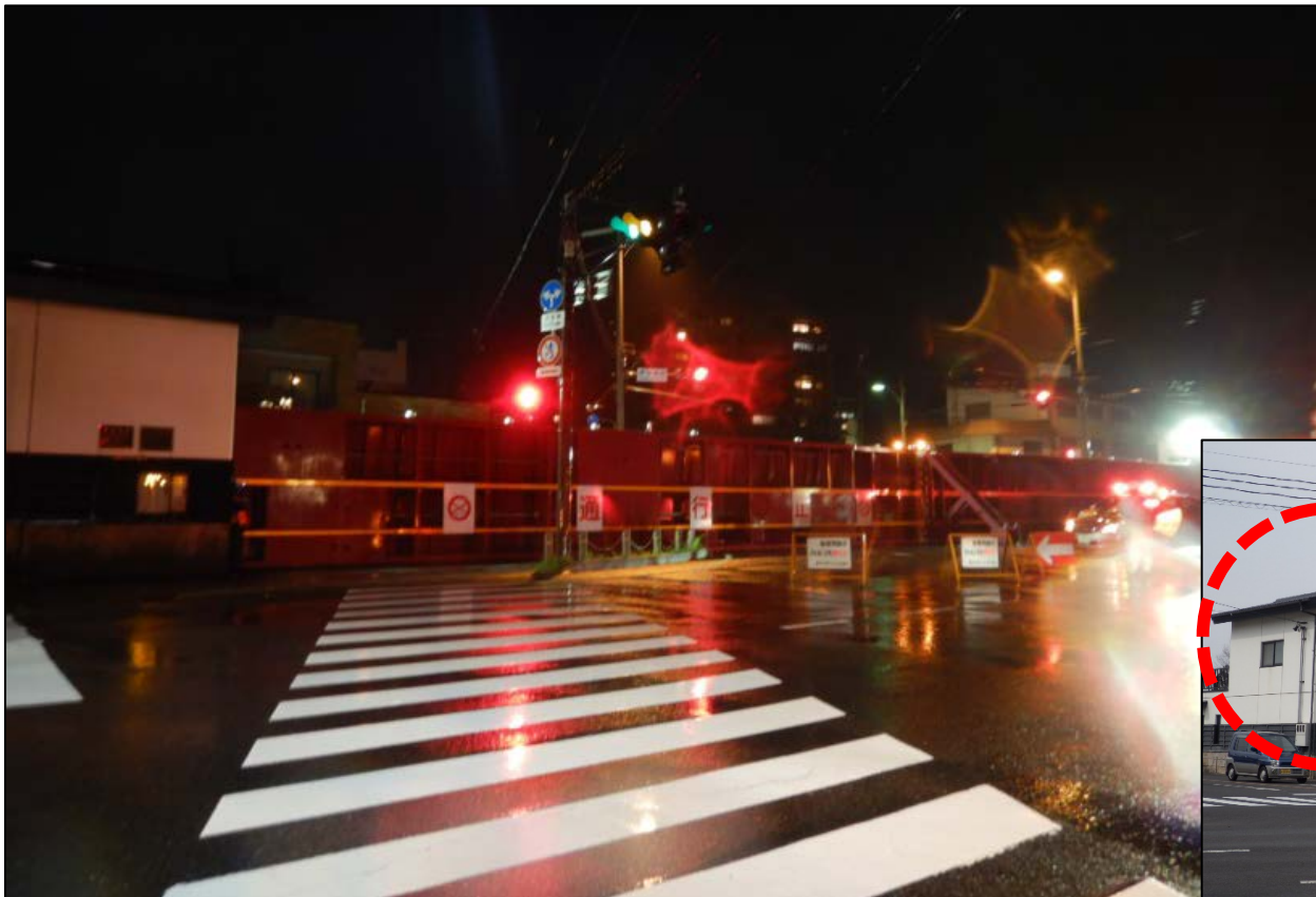
平成30年7月8日 大宮陸閘を閉鎖
