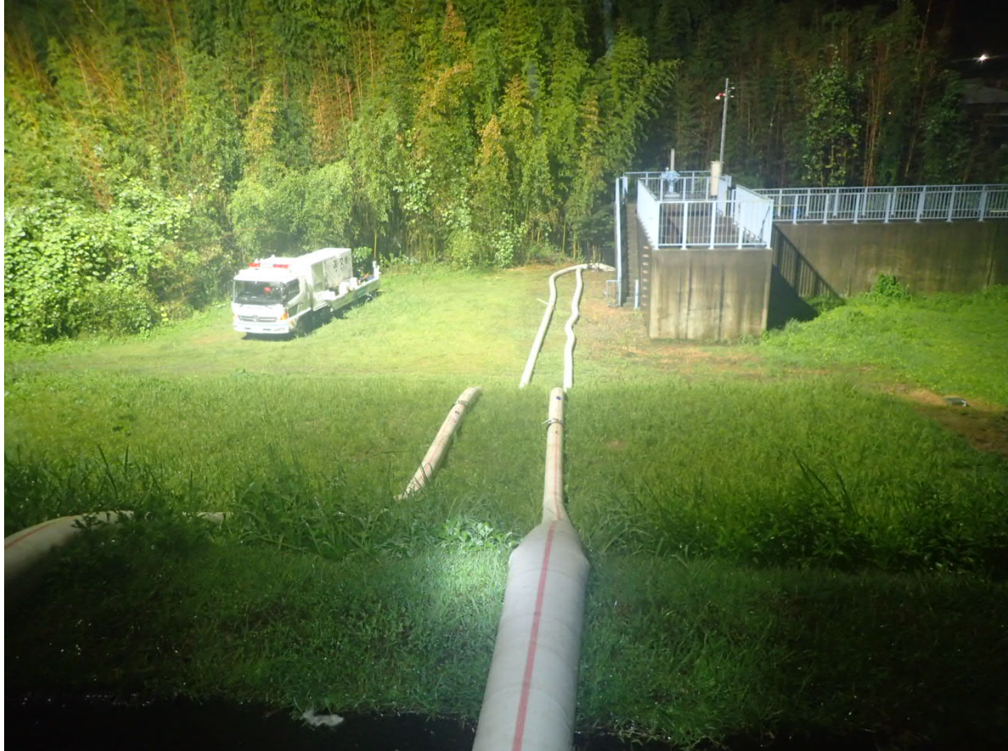
かにし はいすい しゃ さぎょう ようす しりょうていきょう こくどうつうしょう じょうりゅうかせんじむしょ 可見市における排水ポンプ車による排水作業の様子（資料提供：国土交通省 木曾川上流河川事務所）
