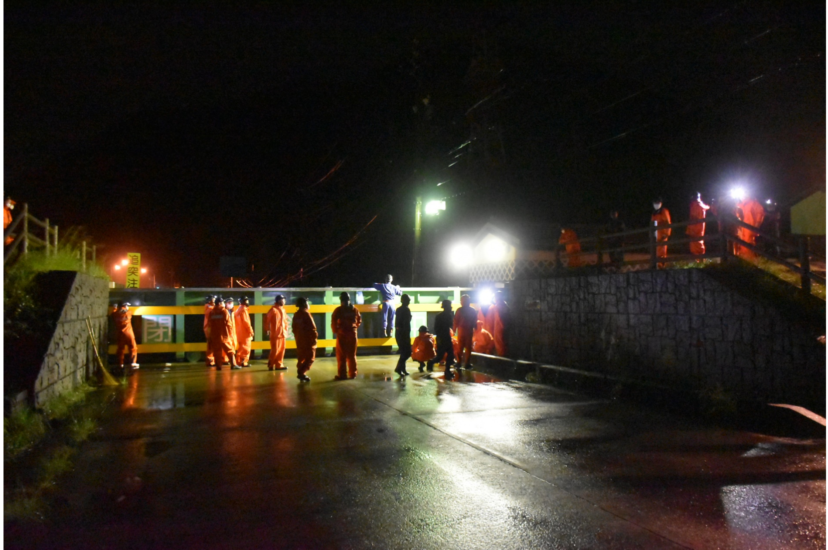
さかほぎちよう かつやまりっこうへいさ ようす しりょうていきょう こくどうつうしりょう じょうりゅうかせんじむしょ 坂祝町における勝山陸閘閉鎖の様子 (資料提供：国土交通省 木曾川上流河川事務所)
