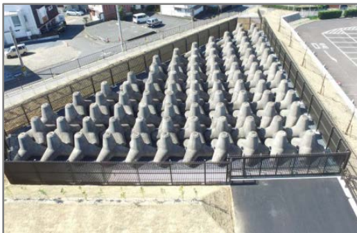
河川防災ステーションに びちく 備蓄されているブロック
