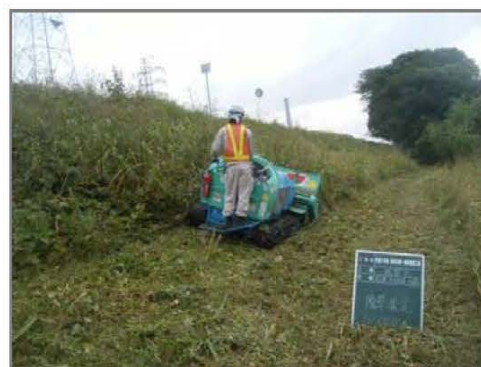
かんり じやそう 堤防法面管理(除草)
