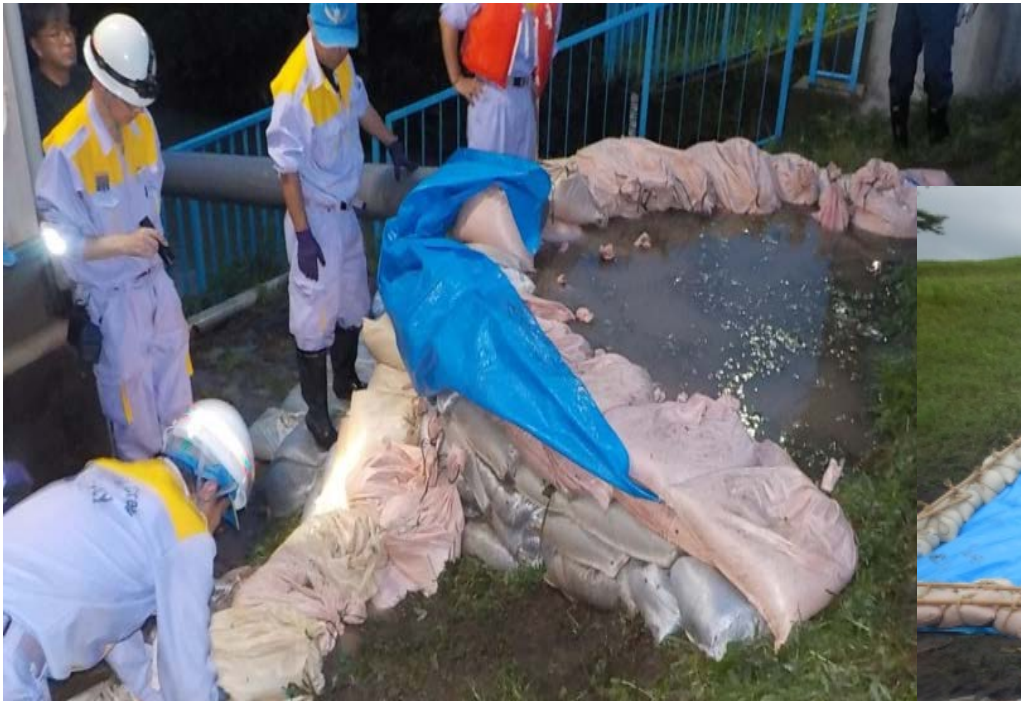
ていぼう ど まる あ 堤防に土のうを丸く積み上げて、あふれた水を安全 なが つき わ こうほう に流します（月の輪工法といいます）
