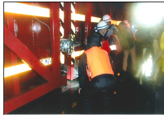
りっこう へいささぎょう 陸閘の閉鎖作業のようす
