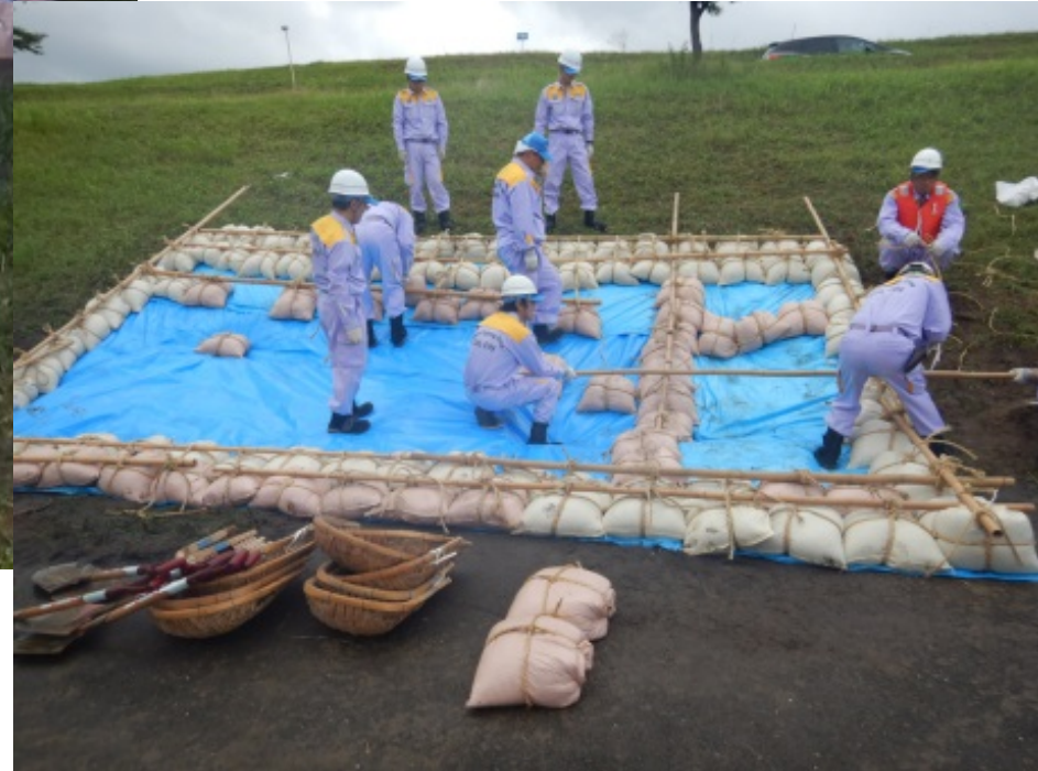
ていぼう うご ど 堤防にはったシートが動かないように土のうをおもりにします
