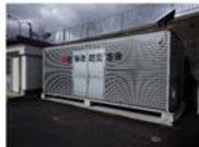
岐阜小学校にある防災倉庫
