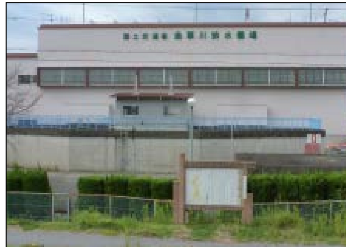
はいすいきじょう 排水機場・ポンプ場操作
