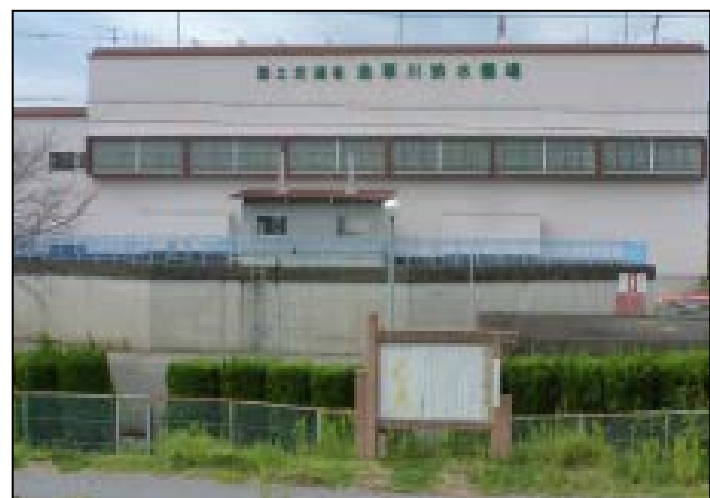
はいすいきじょう 排水機場・ポンプ場
