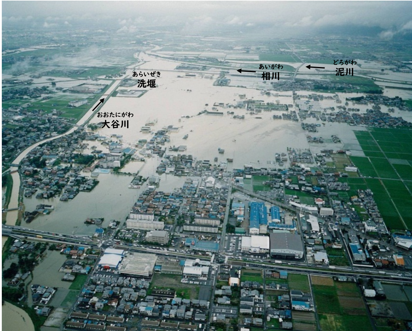
あいかわ おおたにがわ どろがわごうりゅうてんふきんようす しりょうていきょう こくどうつうしょうきそがわじょうりゅうかせん じむしょ 相川・大谷川・泥川合流点付近の様子（資料提供：国土交通省 木曽川上流河川事務所）
