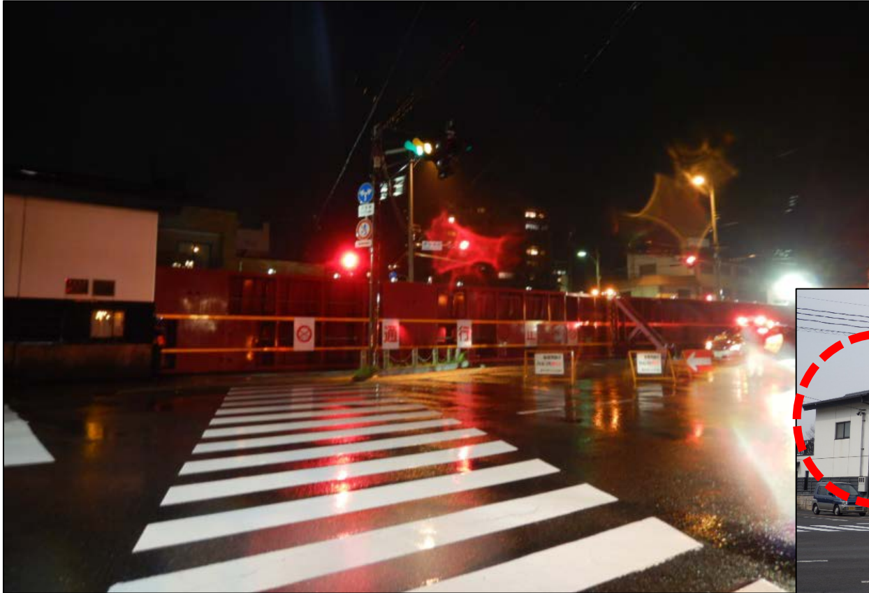
平成30年7月8日 大宮陸閘を閉鎖
