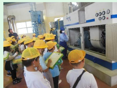
▲糸貫川・天王川排水機場見学 (瑞穂市立本田小学校)
