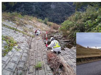
施設状況の確認(堤防・護岸)
