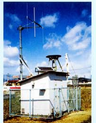
テレメータ雨量観測所
