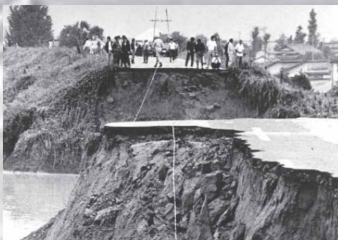
一夜明けた決壊現場。ブロックなど詰め込んで復旧作業
