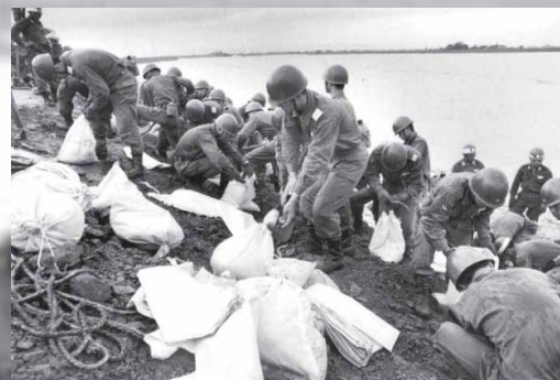
必死の復旧作業 (岐阜新聞より提供)
