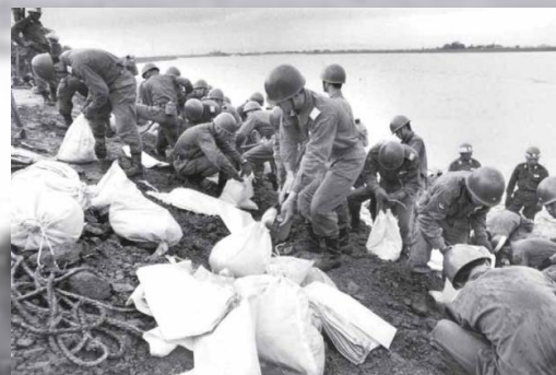
必死の復旧作業 (岐阜新聞より提供)
