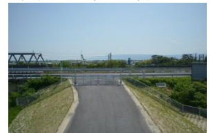
開 木曽川右岸緊急開口部 (平成30年3月完成)
