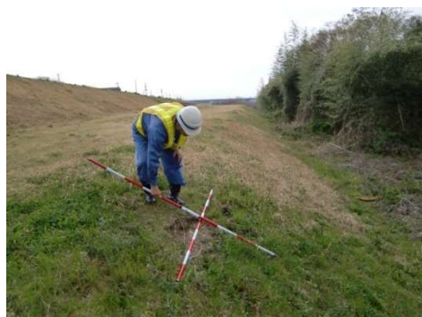
河川巡視状況
