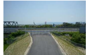
開 木曽川右岸緊急開口部 (平成30年3月完成)
