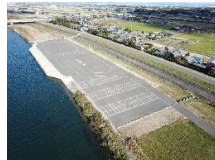
船 長良川防災船着場 (令和元年11月完成)
