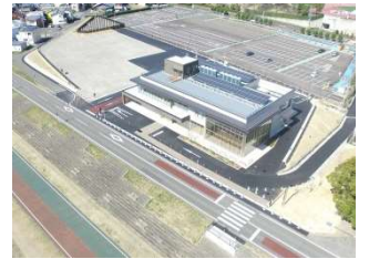
ST 岐阜防災ST (長良川岐阜河川防災ステーション)
